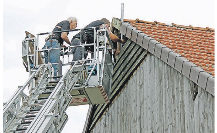
Die Vorbereitungen auf dem Scheunendach laufen.
